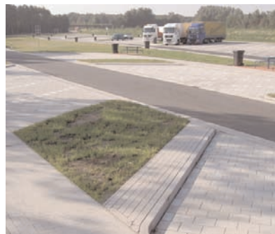
Eine der modernsten Rastanlagen an der A1 nach der Fertigstellung. (Ostseite), September 2009
