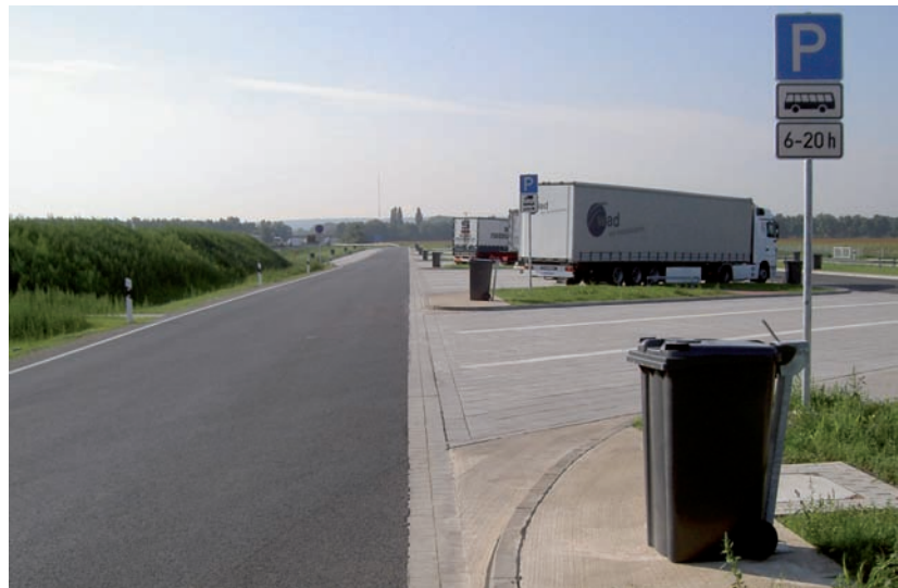
Rastplatz (Westseite): Fertiggestellte Lkw-Parkplätze. Im Vordergrund Busstellflächen. Ganz links (nicht im Bild) verläuft die A1 Richtung Osnabrück.
