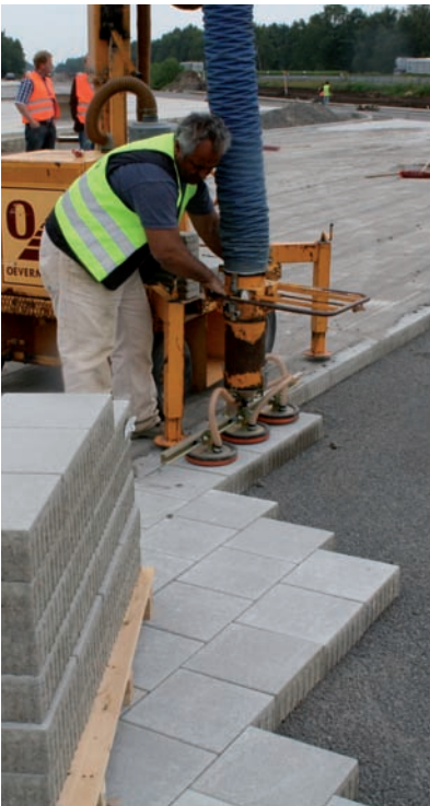
Maschinelle Verlegung der Lkw-Parkplätze mit VS 5 im April 2009. (Westseite)
