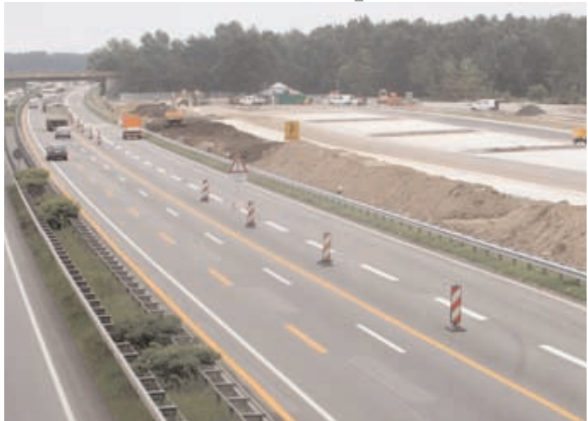
Rastanlage (Ostseite) an der BAB 1, Fahrtrichtung Bremen, während der Erschließungsmaßnahmen im April 2009.
